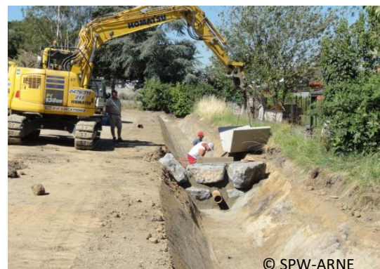
Figure 36 : rénovation d'un fossé
