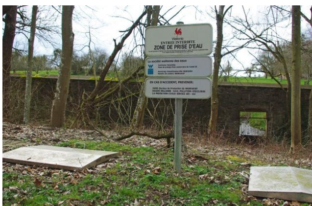
Figure 33 : Captage dans le parc du Castel (Beauraing)
