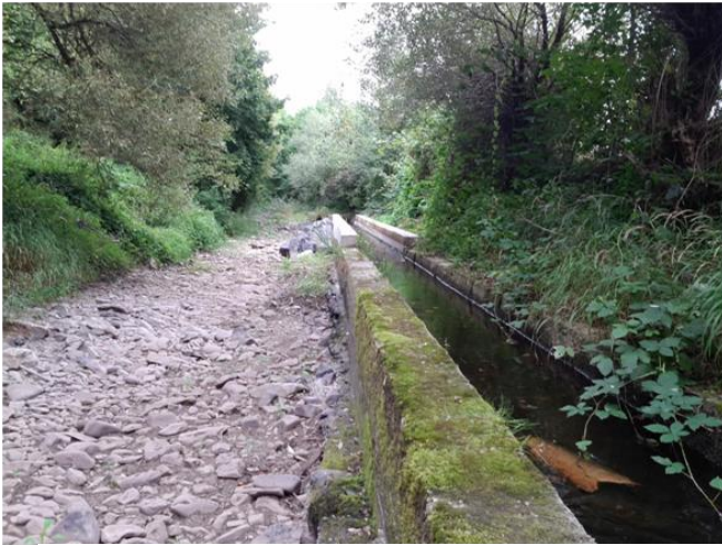
Figure 22 : Cunette Lhoist (Marche-en-Famenne)
