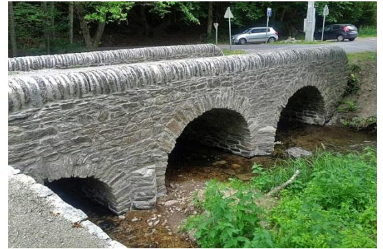
Figure 43 : Pont des Gades sur l'Almache à Gembes (Daverdisse)
