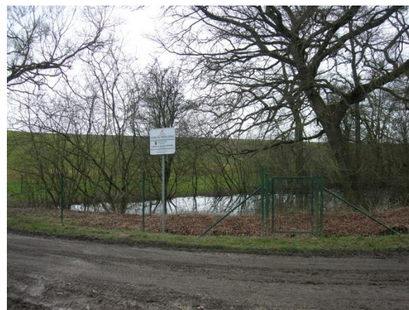
Figure 32 : captage ' Neuve Fontaine' à Rochefort
