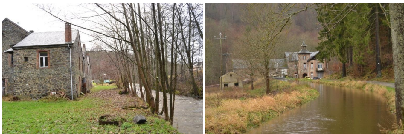
Figures 49 et 50 : centrales hydroélectriques à Poix-Saint-Hubert
