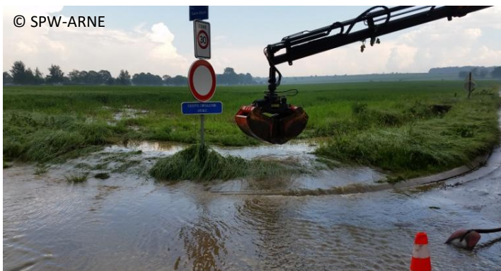
Figure 35 : entretien du cours d'eau
