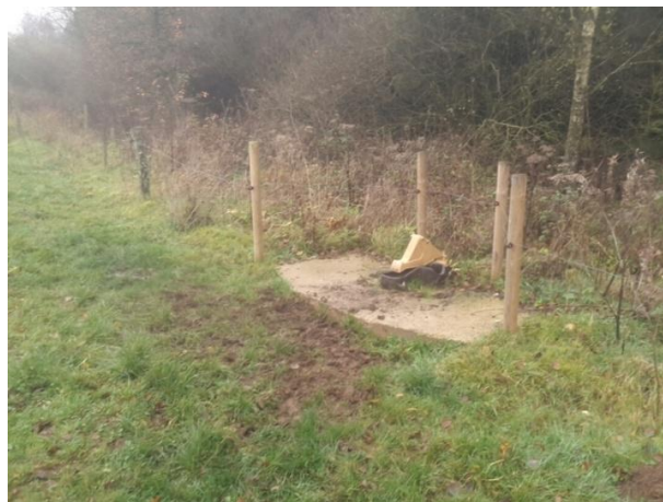
Fig. 54 : pose d'une pompe sur le Ruisseau des Raymonds (Bièvre)
