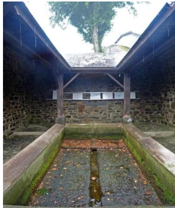
Figure 42 : Lavoir de la Maladrie - Rau de Chermont Saint-Hubert
