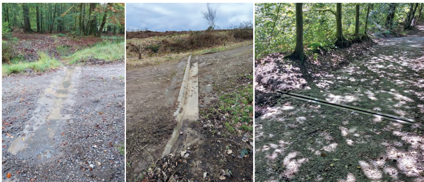
Figure 12 : A gauche, filet d'eau de type rigole © Contrat de Rivière Lesse, le 20 janvier 2025 au bois de Bande - Nassogne. Au centre, filet d'eau de type bordure © Contrat de Rivière, le 12 mars 2025 à Roy - Nassogne. A droite, filet d'eau de type rail © Contrat de Rivière Dyle-Gette au Bois de Lauzelle à Ottignies-Louvain-la-Neuve, 2024
