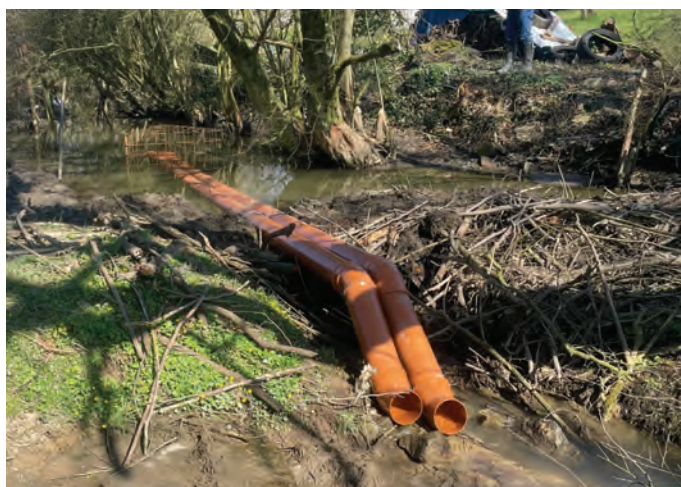
Figure 19 : Cube de Morency placé sur un barrage de castor à Vodecée, avril 2025 à Philippeville - © Commune de Philippeville.
