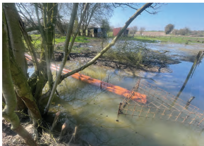
Figure 19 : Cube de Morency placé sur un barrage de castor à Vodecée, avril 2025 à Philippeville - © Commune de Philippeville.
