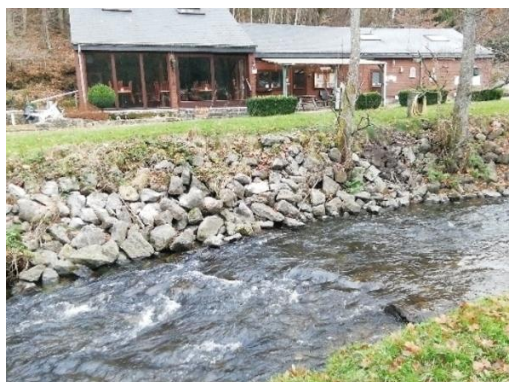
Figures 127, 128, 129, 130, 131 et 132 : exemples de protections de berges recensées.
