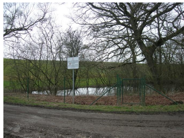
Figure 32 : captage 'Neuve-Fontaine' à Rochefort
