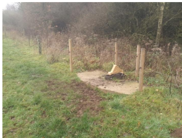
Figure 58 : pose d'une pompe sur le Ruisseau des Raymonds (Bièvre)
