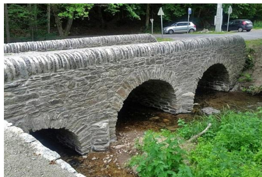
Figure 43 : Pont des Gades sur l'Almache à Gembes (Daverdisse)
