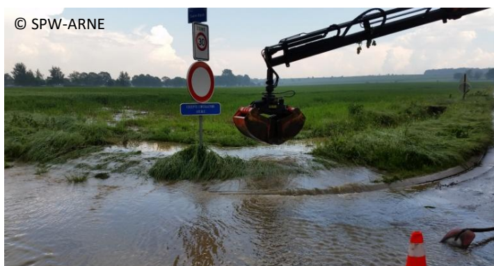
Figure 35 : entretien du cours d'eau
