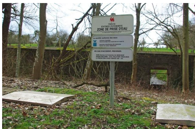
Figure 33 : Captage dans le parc du Castel (Beauraing)
