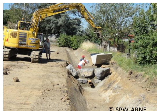
Figure 36 : rénovation d'un fossé
