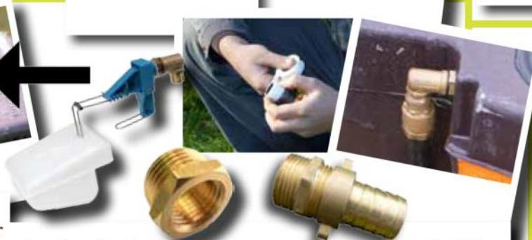
Étape 2 : placer le flotteur dans l'emplacement prévu à cet effet et y raccorder réduction et tétine en assurant l'étanchéité de chaque raccord à l'aide de téflon
