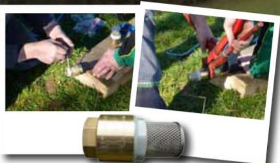
Étape 4 : couper la longueur de socarex nécessaire pour atteindre la zone d'alimentation à une distance maximale du bac de 200m, pour limiter les pertes de charge. Fixer une extrémité au té et la crépine à l'autre extrémité, à l'aide du raccord HUOT préalablement étanchéifié avec du téflon
