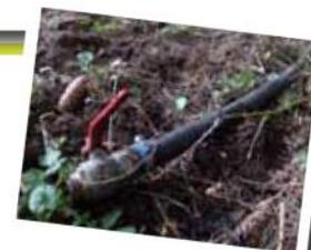
Étape 6 : remplir le socarex d'eau pour amorcer le système et placer la crépine au niveau d'un secteur du cours d'eau profond et caillouteux.
