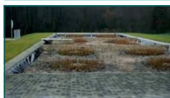
Station d'épuration écologique de Hollange
