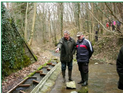
Echelle à poissons sur le Ry des Valennes à Rochefort
