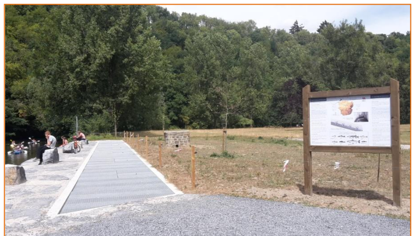
Figure 52 : fin des travaux (juillet 2018)
