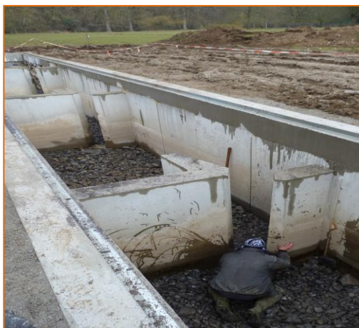
Figure 51 : travaux à Villatoile en mars 2018
