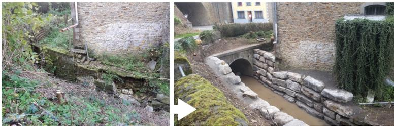
À Grune, commune de Nassogne, le pont enjambant le ruisseau de Bagneux a été restauré. Ses fondations présentaient des signes d'érosion. Afin de permettre la libre circulation des poissons, des enrochements ont été répartis à l'aval de l'ouvrage pour former « un escalier » franchissable (action 17Le0287).
