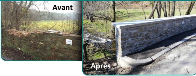
**R**emettre un couvre-mur sur la rambarde du pont enjambant le Leupont près du moulin d'en haut à Hatrival. Les ouvriers de la commune de Saint-Hubert ont restauré la maçonnerie et le couvre-mur du pont en mars 2019.
