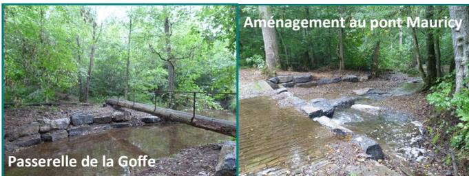
Au niveau du ruisseau de Leupont, au captage du petit maçon, les berges ont été stabilisées afin d'éviter le débordement du cours d'eau sur le captage. La commune a profité de la présence de l'entrepreneur pour remplacer le tuyau sous le pont par un pertuis. Ce type d'aménagement présente plusieurs avantages par rapport à un tuyau. Le
