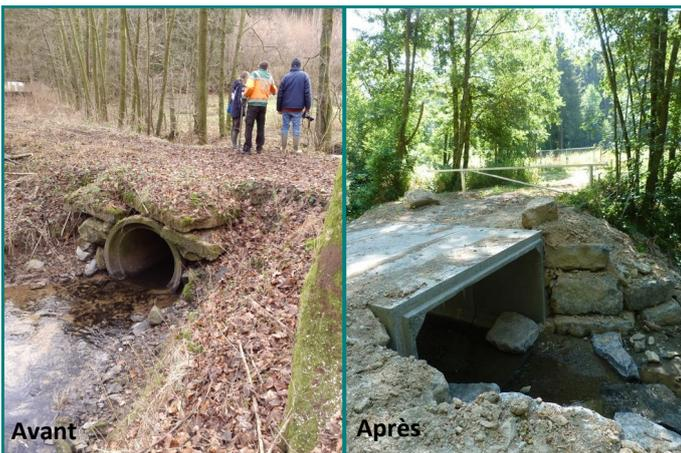
pertuis, quand il est bien enfoncé dans le lit du cours d'eau (plafond) : a) respecte davantage la morphologie naturelle du ruisseau; b) est moins susceptible de se boucher avec des branchages; c) un substrat naturel (graviers,...) vient s'y déposer; d) grâce à sa dimension plus importante, il est capable d'accueillir de plus grandes quantités d'eau (en cas d'orage par exemple).
