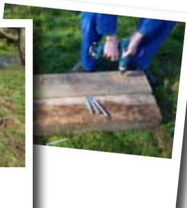
Étape 1 : préparer le sol, mettre à niveau le socle, forer les trous pour les fers à béton et les tire-fonds
