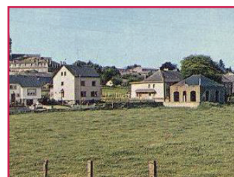
Le lavoir des Frênes [sur la droite] avant sa destruction.
