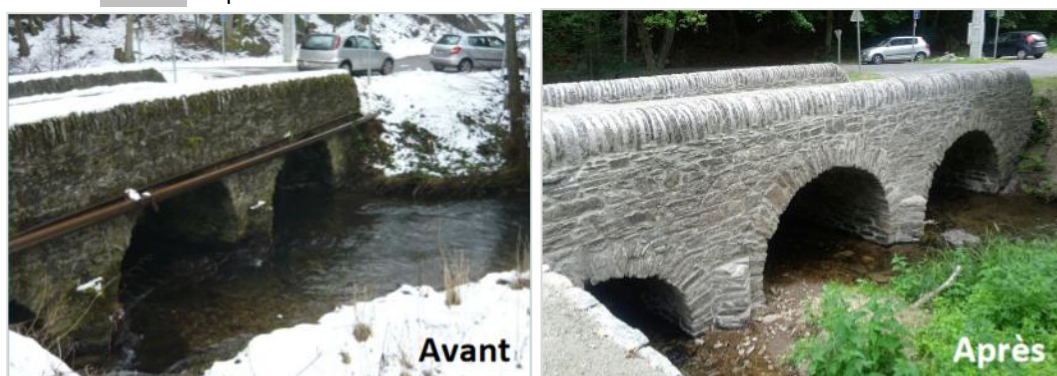
Figure 59 et Figure 60 : 'Pont des Gades' : avant / après
