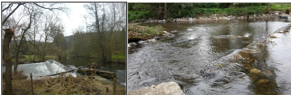
Figure 114 et Figure 115 : travaux passe à poissons - Belvaux avant-après
