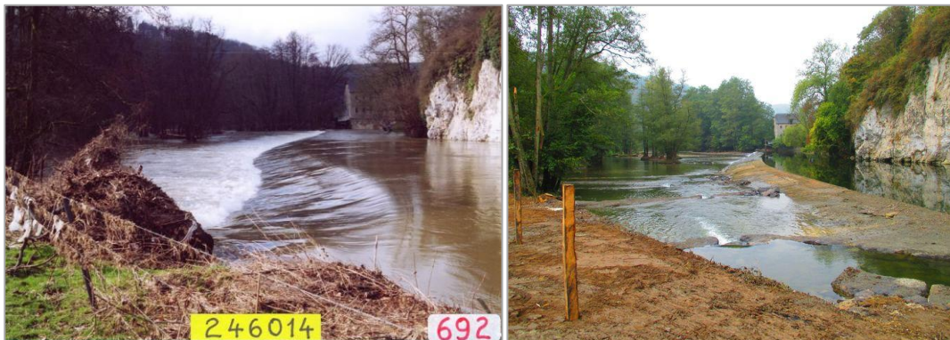
Figure 110 et Figure 111 : travaux passe à poissons Walzin avant-après
