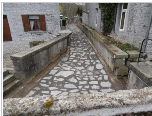
Figure 104 : travaux d'égouttage à Celles
