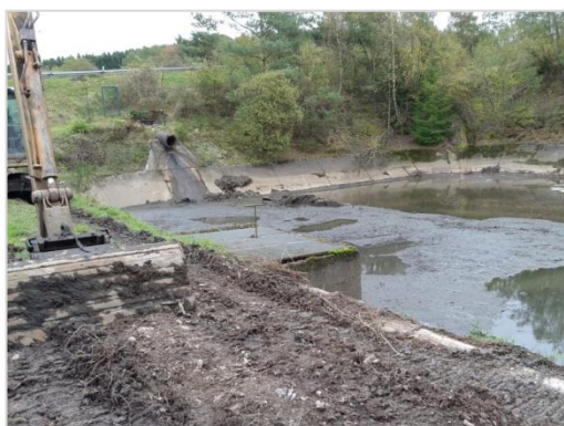
Figure 78 : curage du BO à Resteigne
