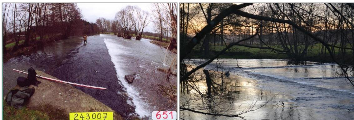
Figure 112 et Figure 113 : travaux passe à poissons Villers-sur-Lesse avant-après
