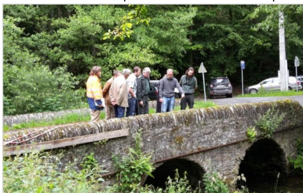
Figure 80 : réunion 'Pont Gades' avec entrepreneur 30/6/16
