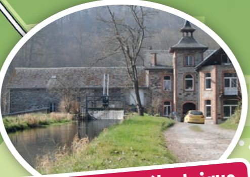
Centrale hydroélectrique Pont-à-Smuid
