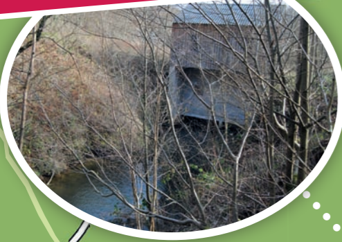
Centrale hydroélectrique Louis Zoude (Hydroval)
