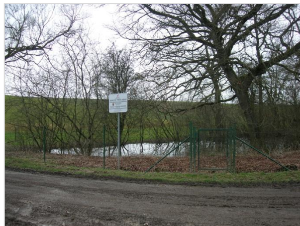
Figure 26 : captage ' Neuve_Fontaine' à Rochefort
