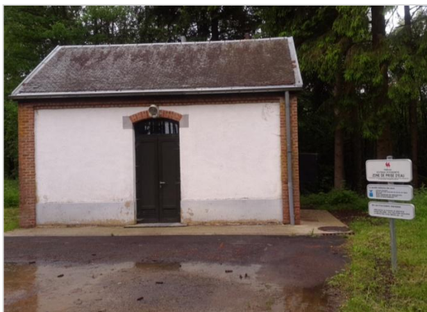
Figure 25 : captage à Haut-Fays (Daverdisse)
