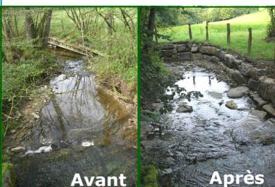
Retirer ou faire retirer les poteaux en béton en berge du ruisseau de la Fosse, rompre le seuil juste à l'aval du pont avec des enrochements disposés sur le plafond du ruisseau (obstacle à poissons) à la sortie d'Ambly vers Hargimont. Cette action a été résolue par la Direction des Services Techniques de la province de Luxembourg, service cours d'eau.
