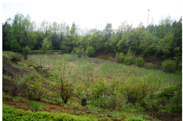
Bassin d'orage de Luchy
