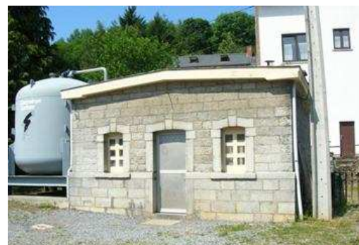
Captage Tamizon E1
